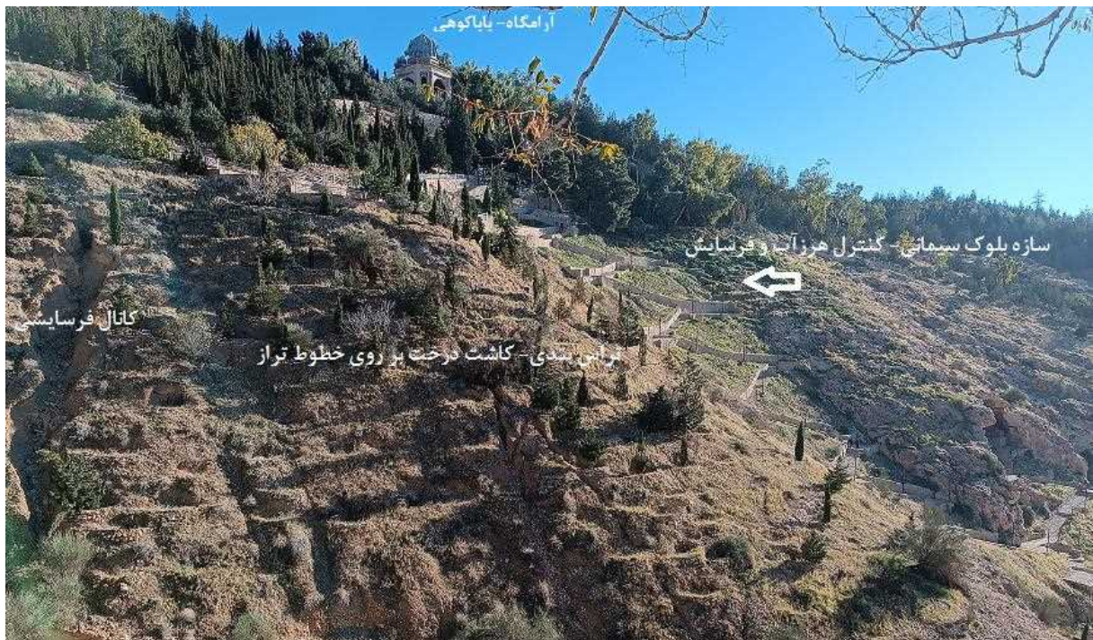
شکل ۱۴. کنترل سیل و رسوب با ایجاد سازه، تراس‌بندی و درختکاری و نیاز به نگهداری عملیات در آبخیز (عکاس: حسینی مرندی، ۱۴۰۴)
